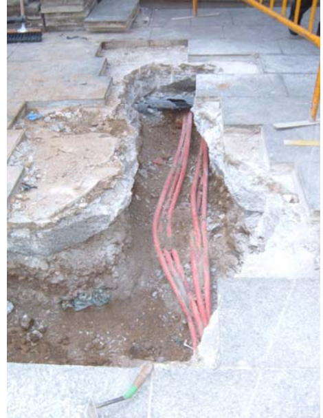
Foto 2. Vista parcial de la rasa1; en primer terme els serveis localitzats.
