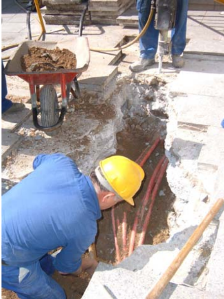
Foto 1. Realització de la rasa 1.
