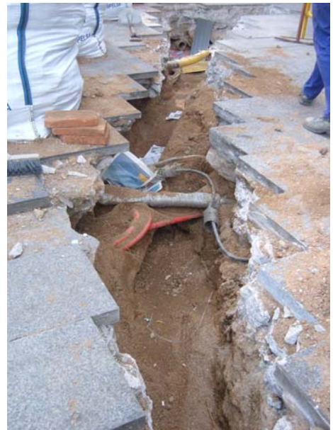
Foto 2. Vista parcial de la rasa1; en primer terme els serveis localitzats.
